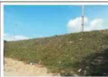
Talude do Platô
